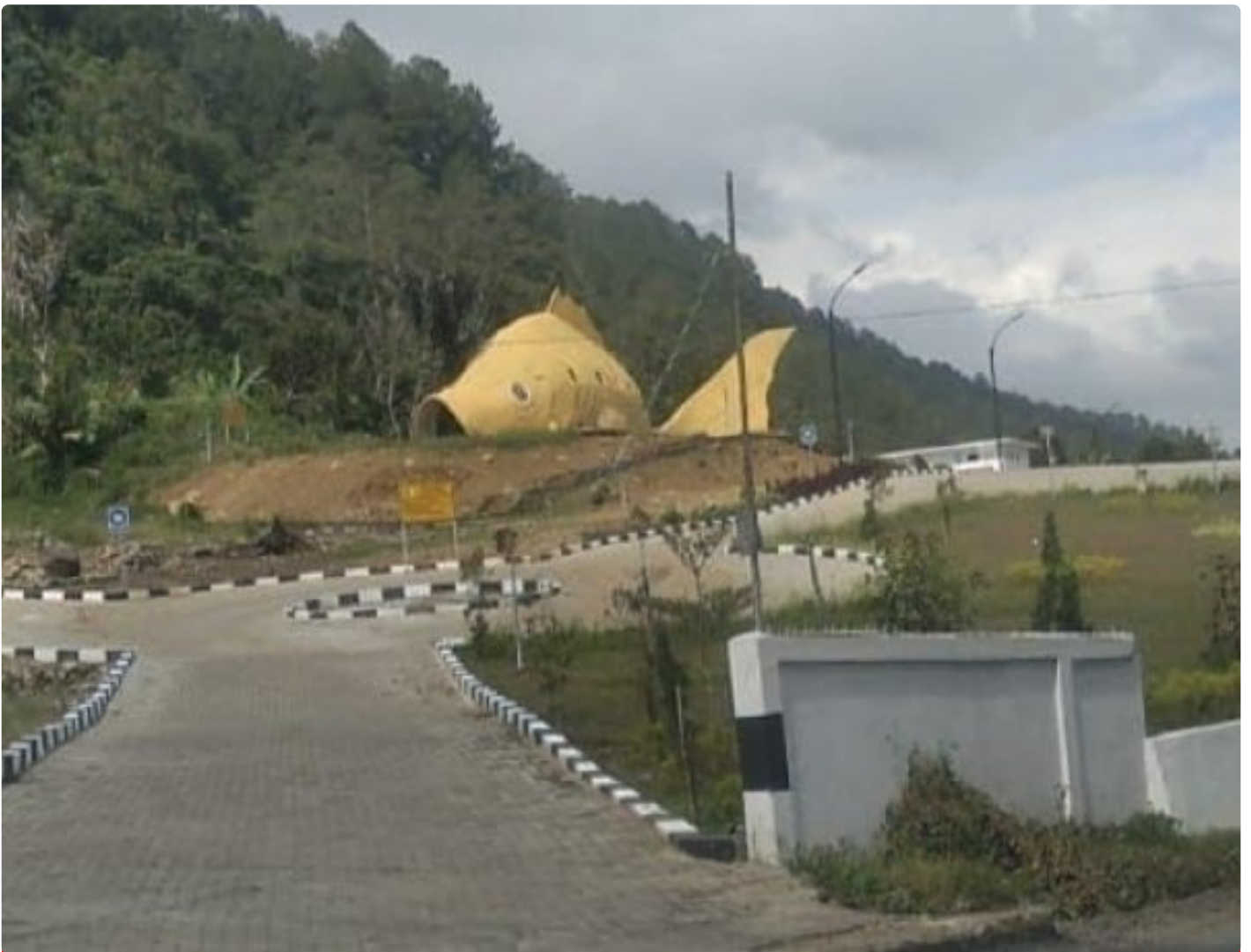
Proyek Pembangunan Ikan Mas Sipolha
